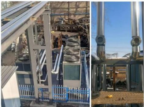
图 6 空气源热泵机组实物图
