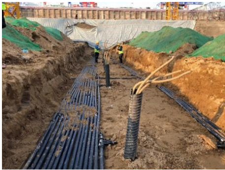
图 6 地源热泵与抗浮锚杆交叉区域
