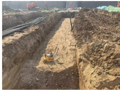
图 9 基坑内水平沟级配砂石回填
