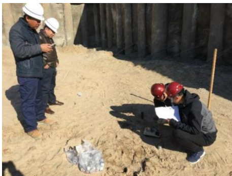
图 8 基坑内水平沟回填环刀取样
