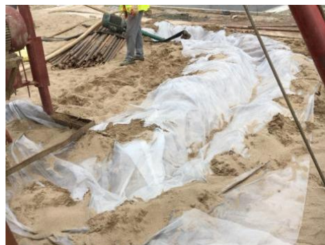
图 2 泥浆沟敷设塑料布
