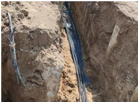
图 7 地源热泵与工程桩交叉区域
