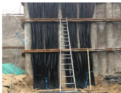
图 11 非集式管埋管沿支护桩敷设
